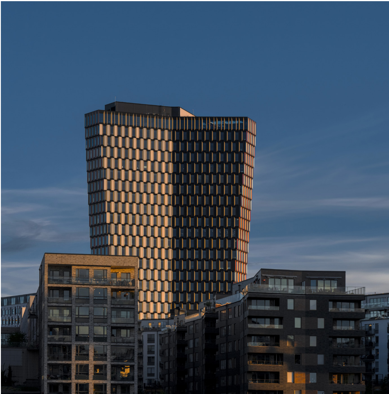
Skanska Sthlm 01 i Hammarby Sjöstad med etablerat passivt antennnät
